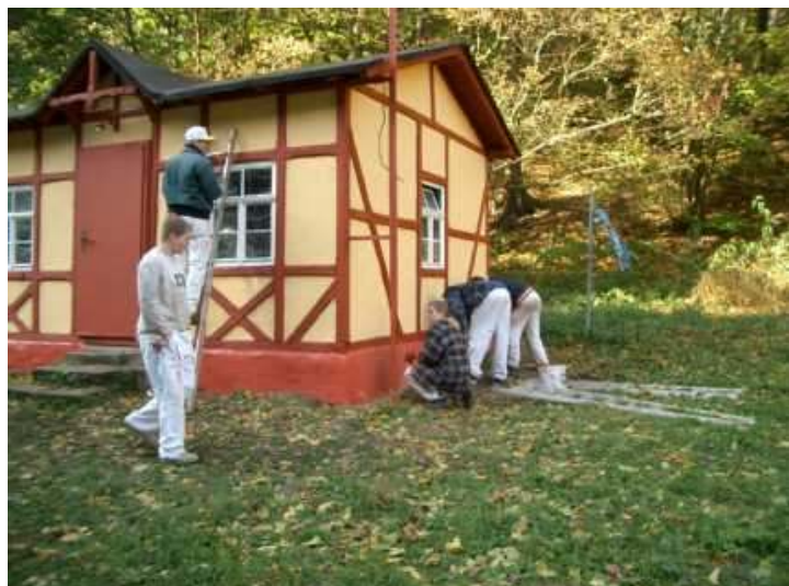
Schlussanstrich des Sockels mit Dispersionssilikatfarbe
