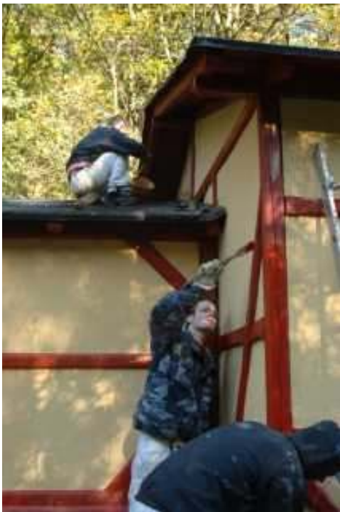
Schlussanstrich der Dachuntersichten/ Fachwerk mit Dispersionsfarbe
