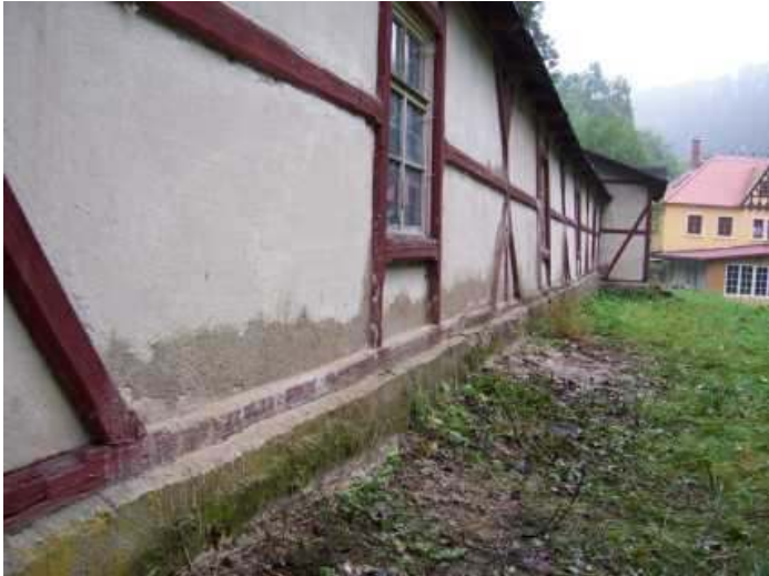
Überprüfen des Untergrundes durch Augenschein und Sockel freilegen
