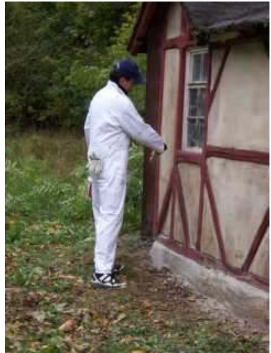
Fenster / Tür mit Bläueschutz streichen
