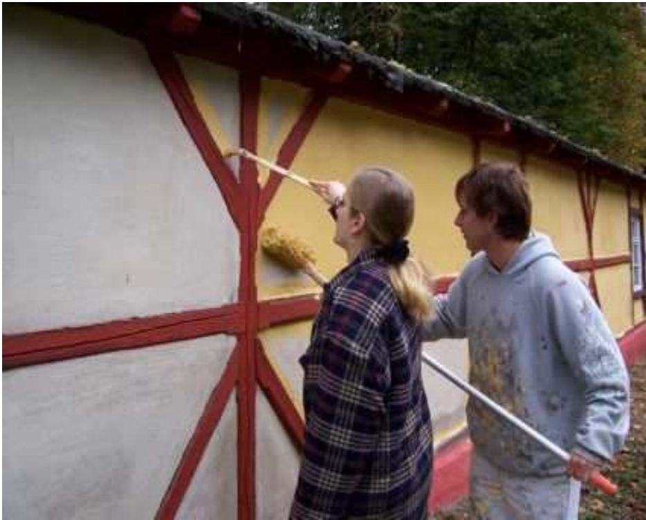
Zwischenbeschichtung der Gefache mit Dispersionssilikatfarbe
