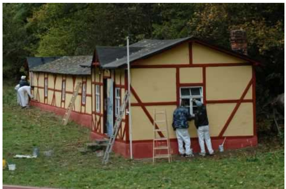
Schlussanstrich der Fenster ( Fensterlack) und Tür (mit Dispersionsfarbe)
