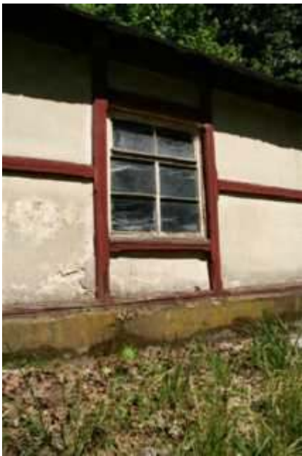
abgeblätterte Kalkfarbe, Verschmutzungen,
