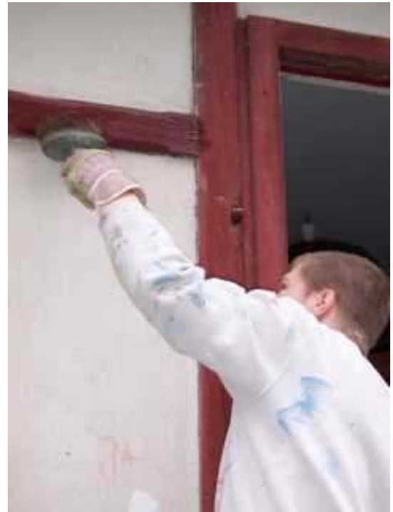
Fachwerk mit Bläueschutz imprägnieren
