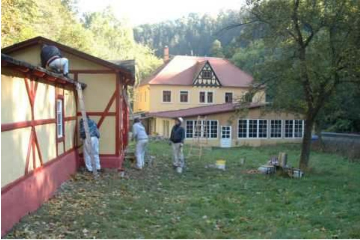
Schlussanstrich des Gefaches mit Dispersionssilikatfarbe
