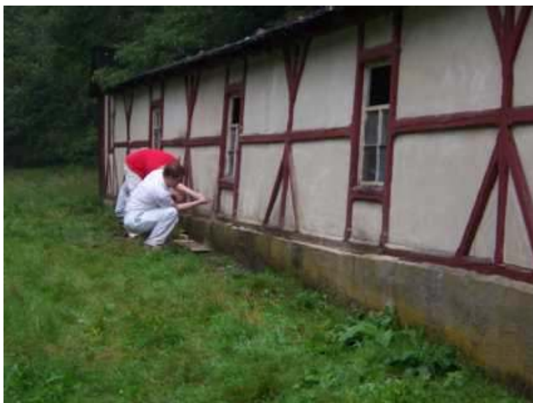
Extrem lose Altbeschichtungen entfernen
