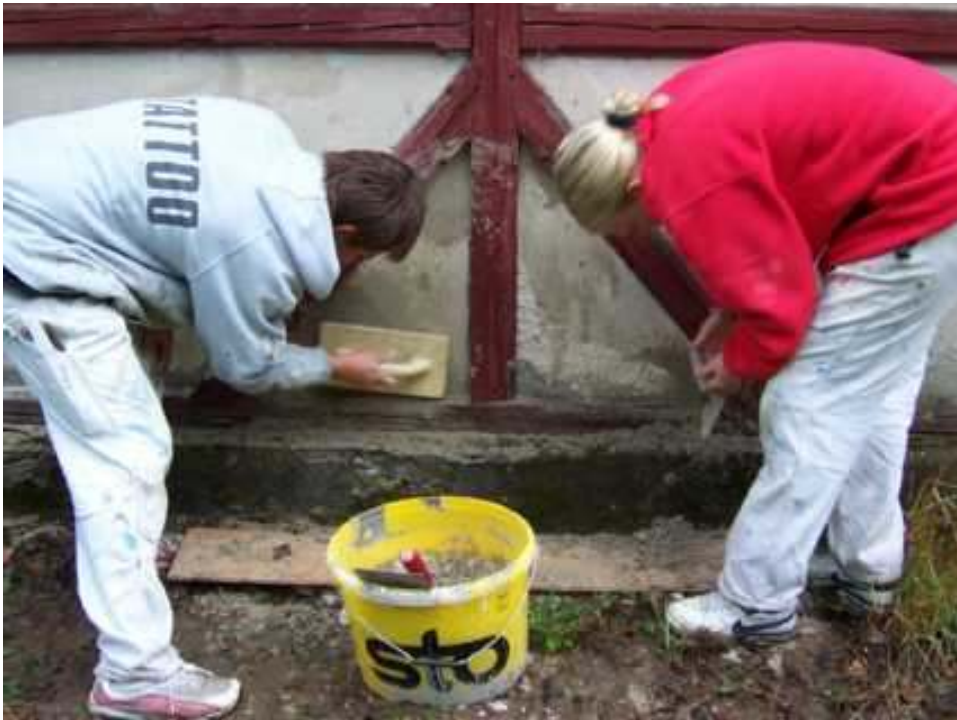
Putzschäden ausbessern
