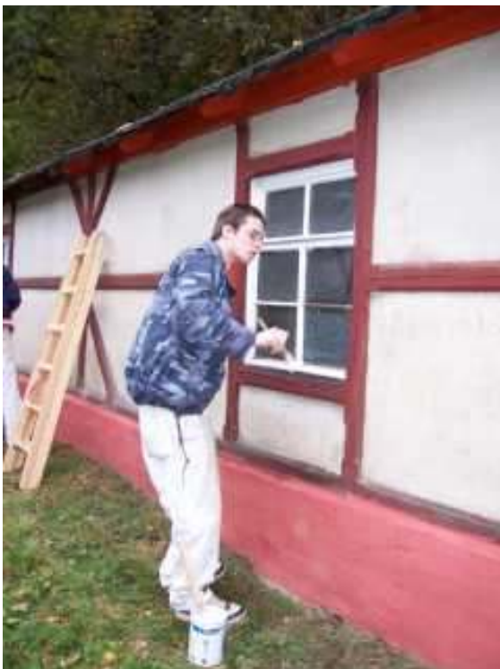
Fenster und Tür mit Vorstrich streichen
