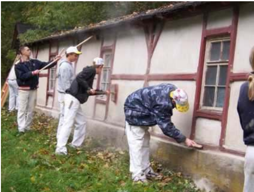
Abbürsten des Gefaches und des Fachwerks
