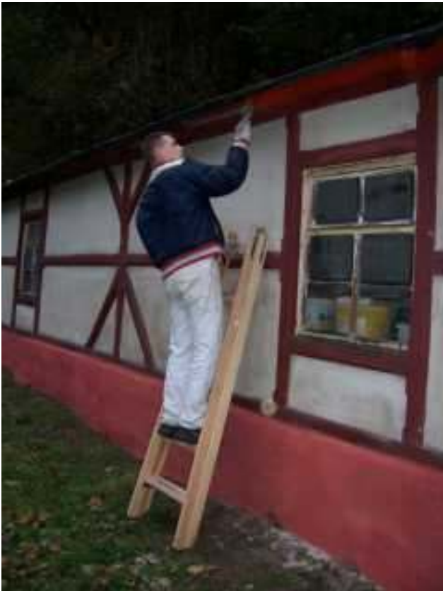
Zwischenbeschichtung der Dachuntersichten/Fachwerk mit Reinakrylat-Dispersionsfarbe
