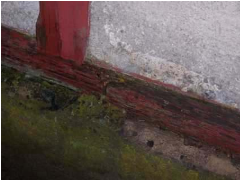
abgewittertes Holz (Tischlerarbeit)
