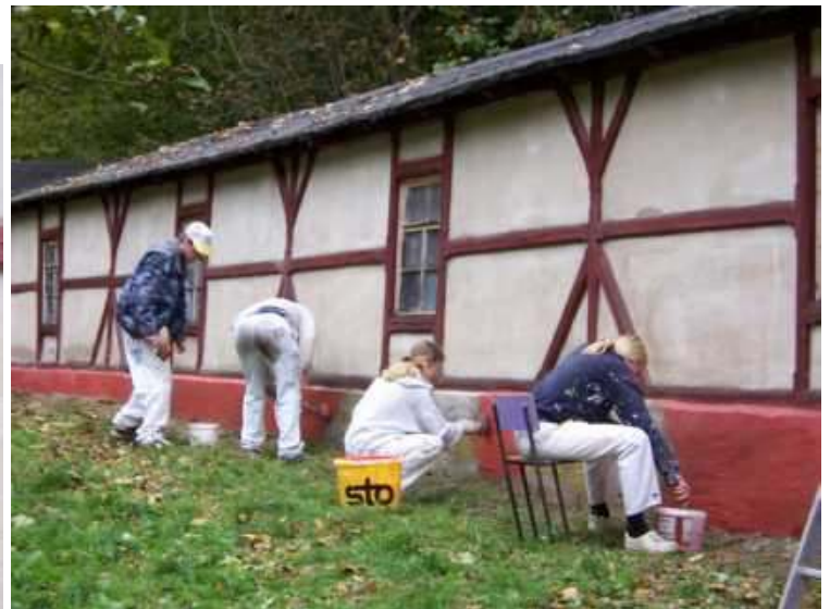
Gefache und Sockel grundieren
