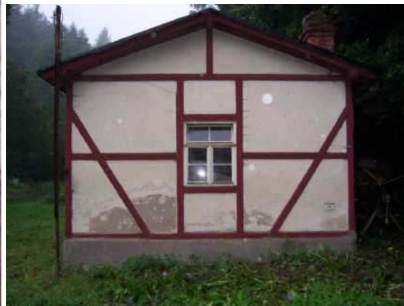
Untergründe prüfen durch Kratzprobe und Augenschein Schäden und ihre Behandlung schriftlich festhalten.
