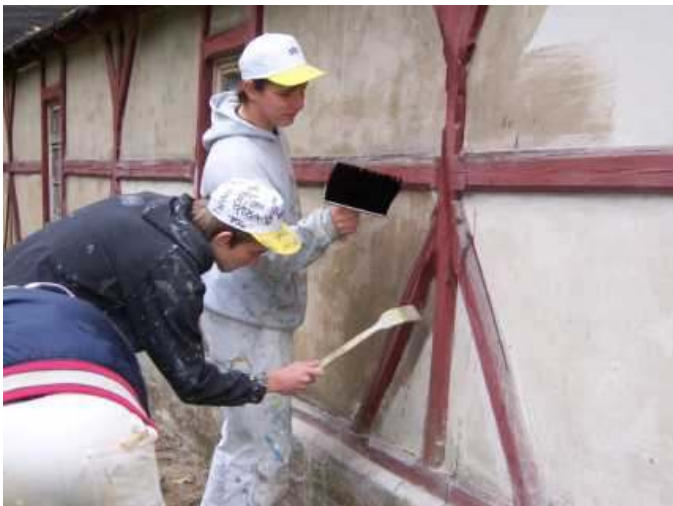
Gefache und Sockel grundieren
