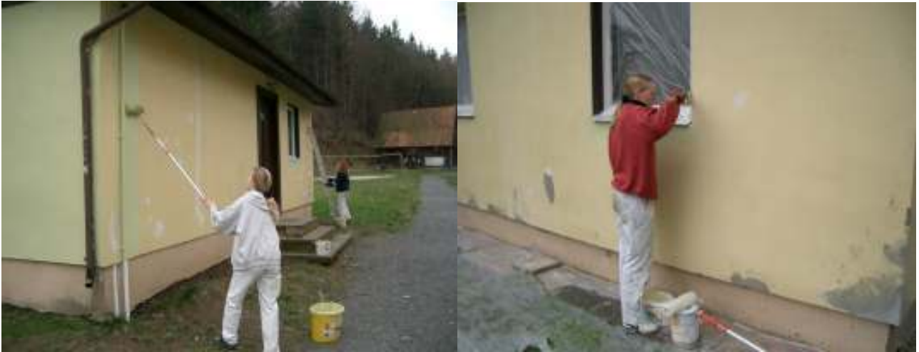
Vorstreichen der Fallrohre, 1. Anstich der Fassade und des Sockels (Einarbeiten des Fallrohres)
