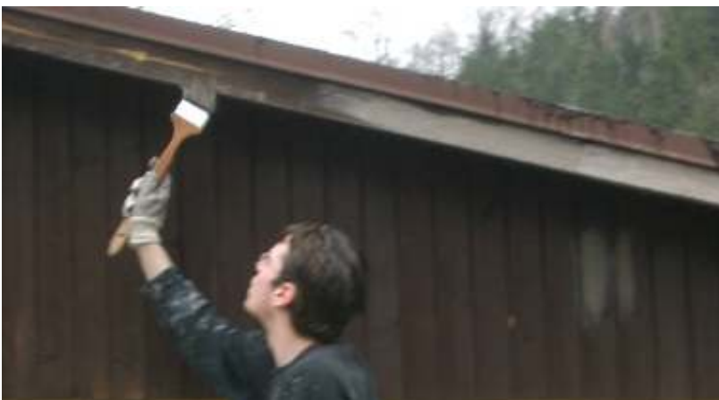
1. Anstich auf Giebel und Dachuntersichten
