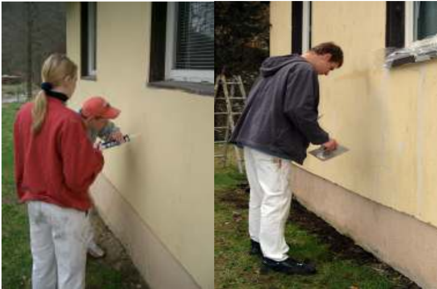
Davor Abstauben der Fassade/ Sockel/ Giebel/ Fallrohr, Risse und Löcher spachteln
