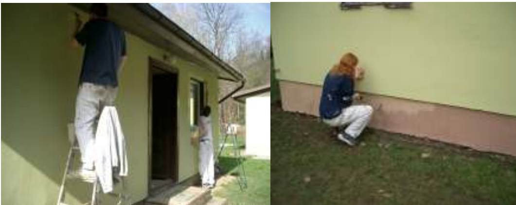
2. Anstrich der Fassade und des Sockels (Einarbeiten des Fallrohres)
