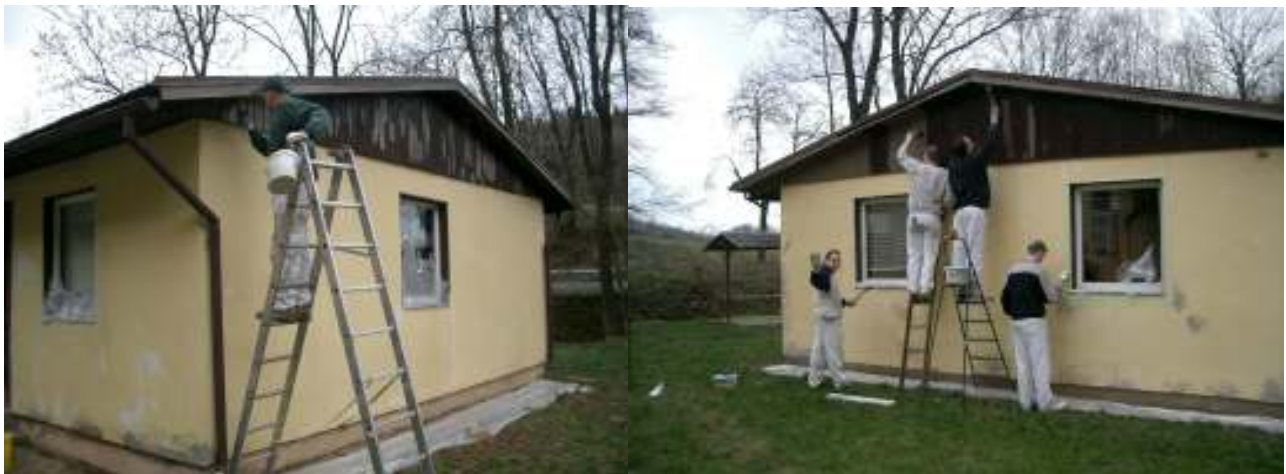
Abdecken, Abkleben der zu schützenden Flächen, 1. Anstich auf Giebel und Dachuntersichten
